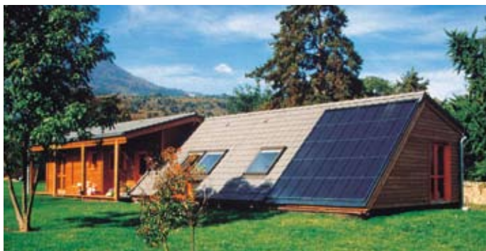
Maison individuelle à Chapareillan (Isère) : occupée par quatre personnes, 16 m 2 de capteurs en toiture (avec chauffage d'appoint couplé par chaudière fioul).
