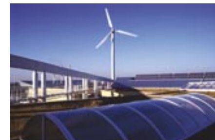
Une éolienne assure une partie de l'alimentation électrique d'un lycée à Calais
